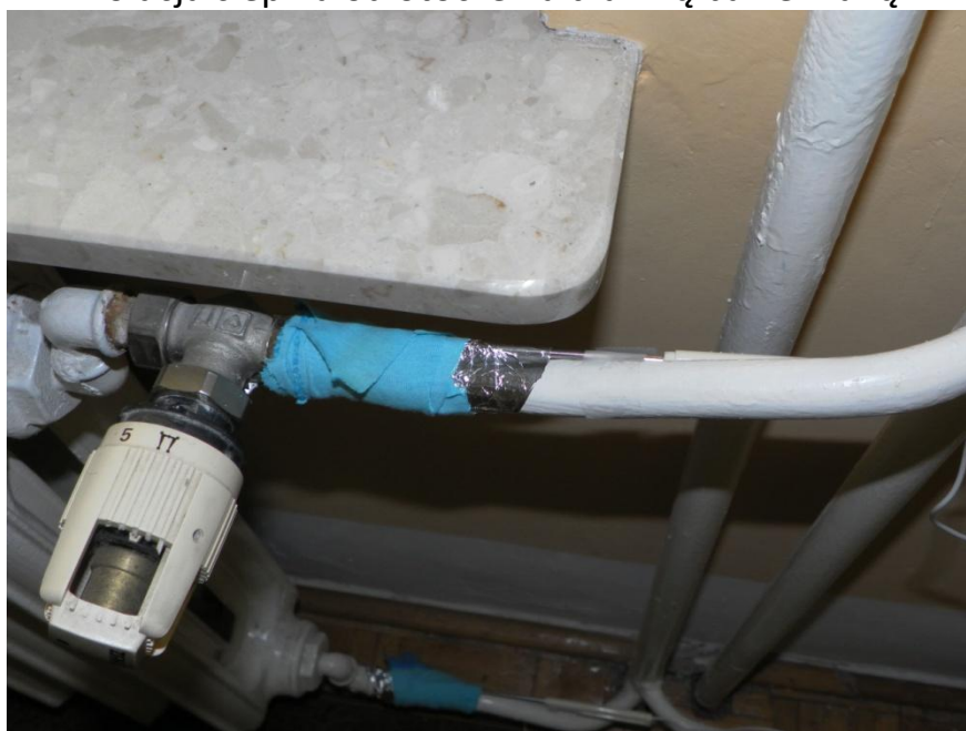
Sondy temperaturowe na zasilaniu i powrocie
