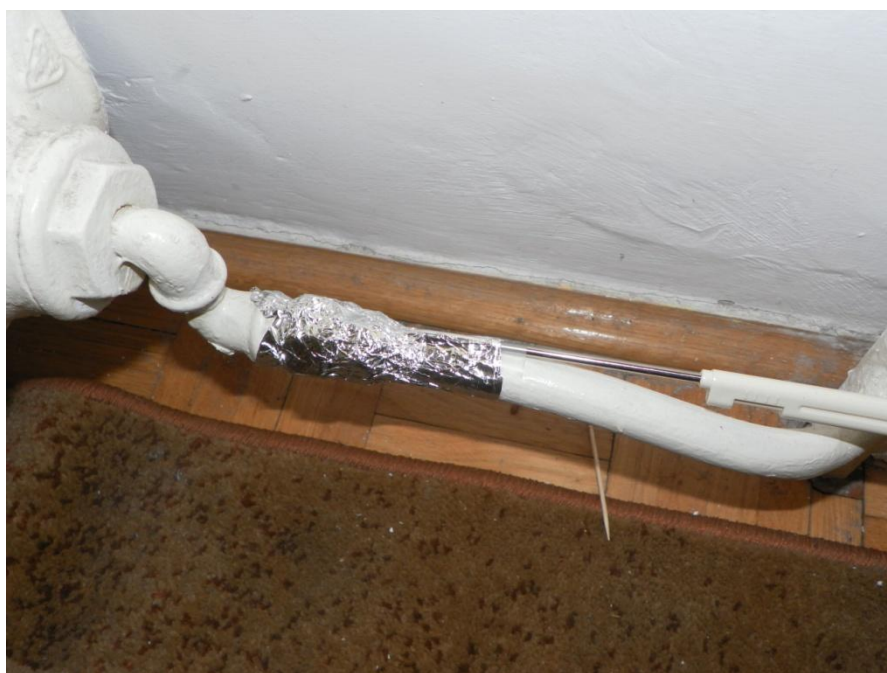
Owiniecie warstwami folii aluminiowej
